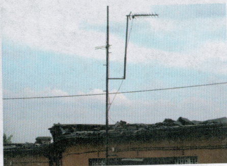
Zniszczenia pokrycia dachowego spowodowane pracą kopalni (ZK Jastrzębie Zdrój)
